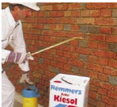
1. mineralizace, hydrofobizace Kiesol
