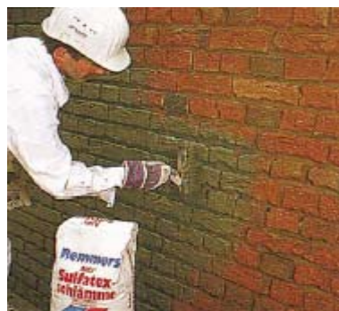
2. první vrstva Sulfatexschlämme
