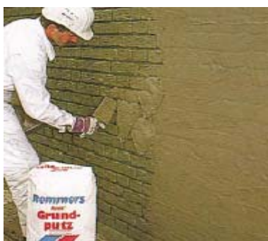
3. vyrovnání podkladu Dichtspachtel
